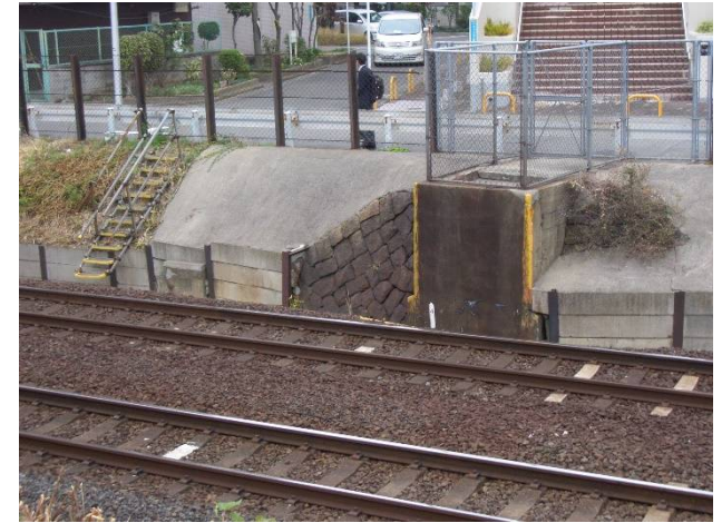
5. 南海高野線下に潜る水路口
