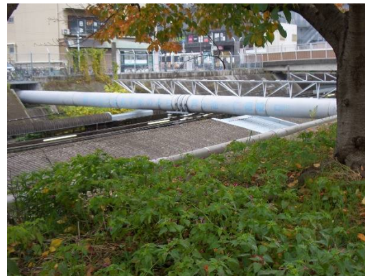
4. JR 阪和線を跨ぐ水道橋
